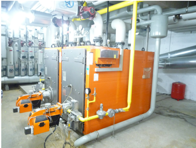
Altbestand Gaskesselanlage
