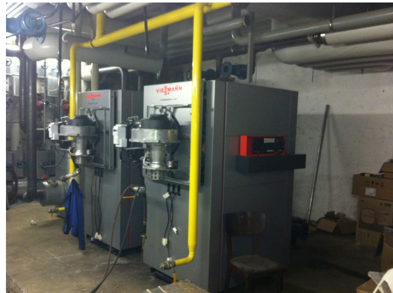
Neue Gasbrennwertanlage
